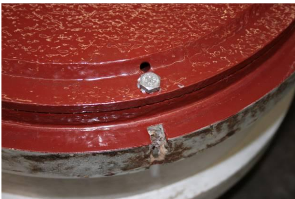
Abb. 14: Lagerdeckel mit Ablaufbohrung
