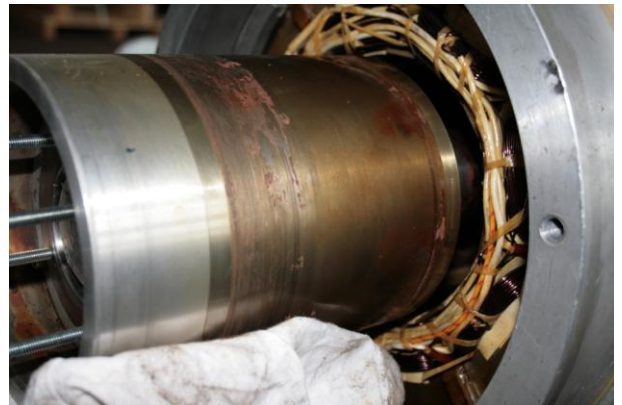
Abb. 8: Rostspuren am DE-seitigen Läuferblechpaket
