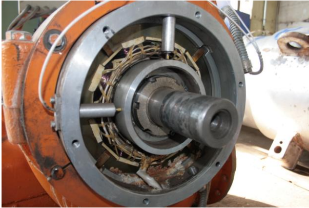
Abb. 5: Radiales DE-seitiges Wellenlagemesssystem in x- und y-Richtung
