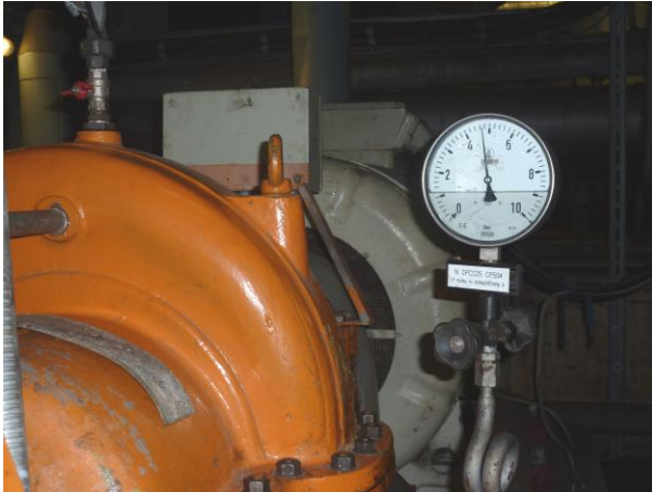
Abb. 18: Pumpbetrieb mit Förderdruck von ca. 4,7 bar
