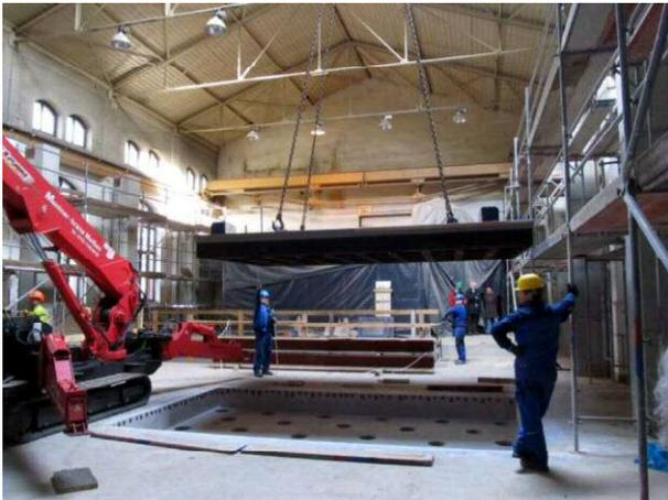
Fig. 7: Einhub der Aufspannplatte
