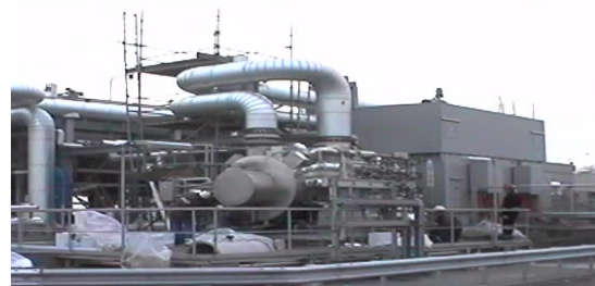
FIGURE 1: AMB Equipped Motor Compressor
